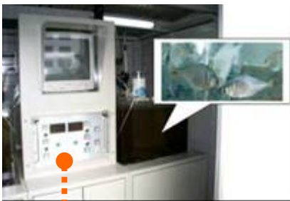
排水の監視 (魚の動きによる有害物質の検知)
